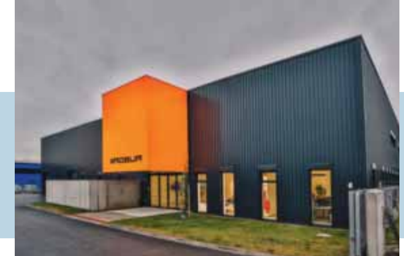
Sídlo společnosti Robur v Popůvkách u Brna bylo dokončeno v roce 2016. Stavba slouží z části pro administrativu a z části jako sklad. Oranžová kostka na fasádě respektuje barevnost loga a v noci svítí.
